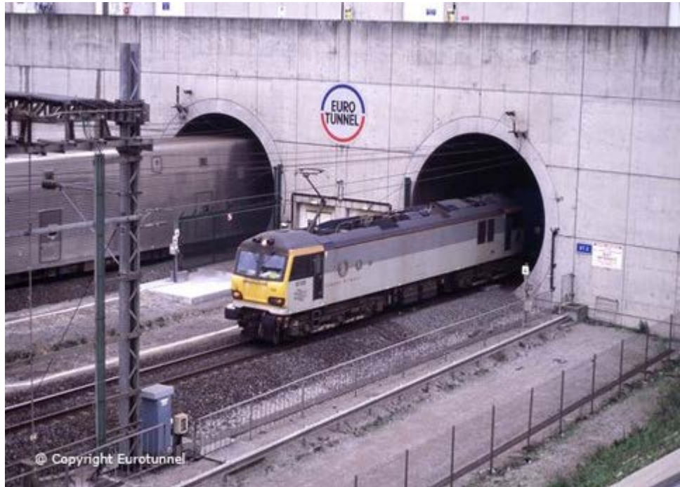
Tunnel sous la Manche
